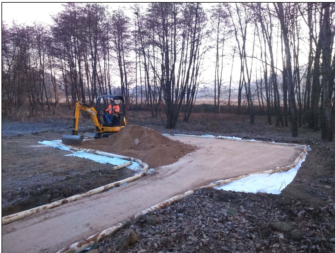
Figura 16. Stesura materiale e delimitazione area mediante cordoli in legno
