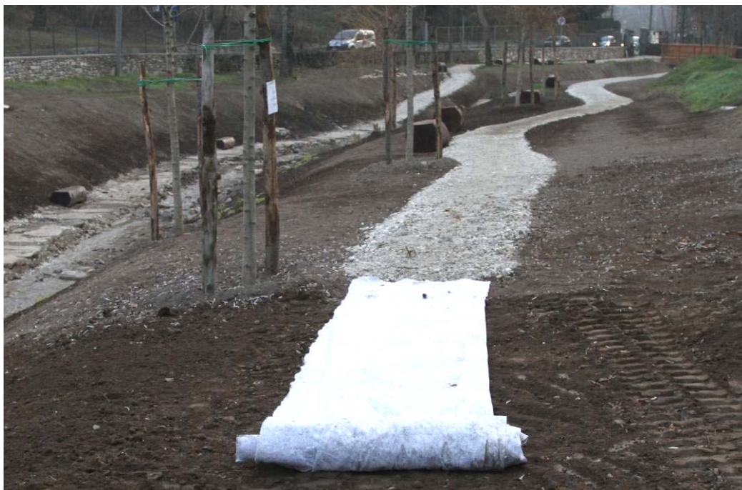
Figura 15. Posa geotessuto sul fondo del sentiero
