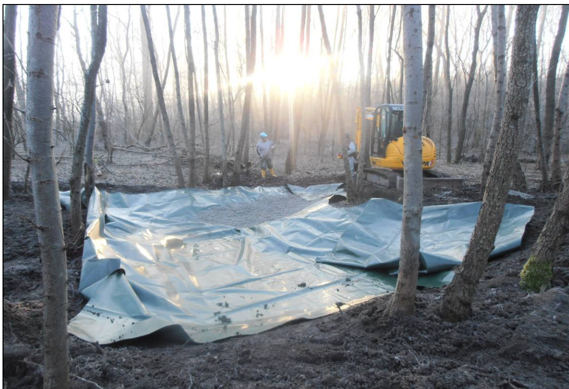
Figura 12. Posa telo impermeabile
